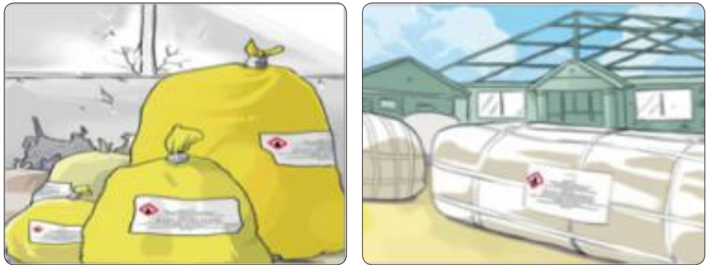
[그림 10-2] 석면함유 폐기물 표시 부착 예시
