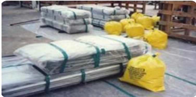
[그림 10-10] 포장된 폐슬레이트와 잔재물
