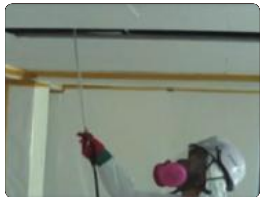
[그림 9-3] 코팅된 천장 텍스 뒷면의 습윤제 분무 예시
