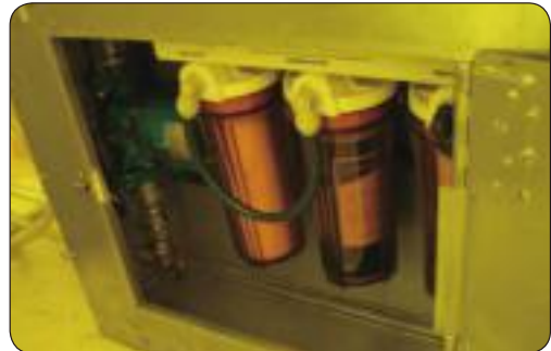
[그림 5-5] 냉온수기 및 배수여과장치 설치 예
