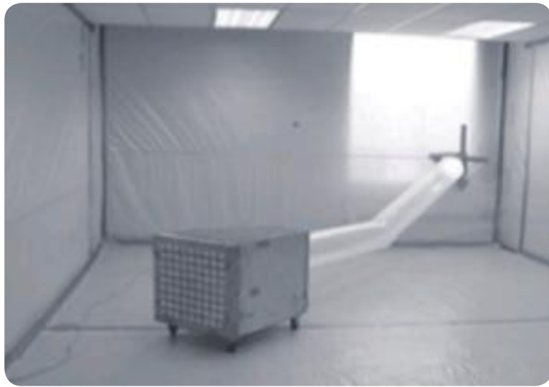
[그림 8-3] 음압기 배출덕트로 비닐사용 예시
