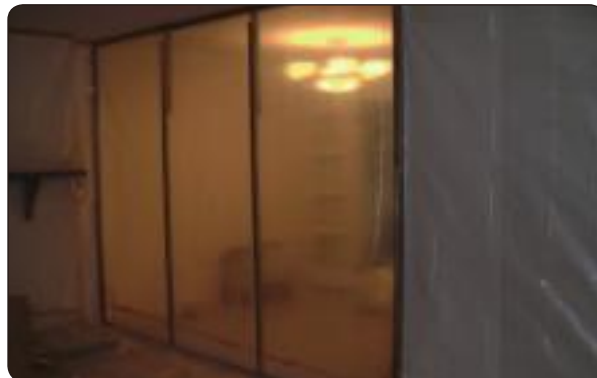
[그림 6-4] 임시벽 설치 사례
