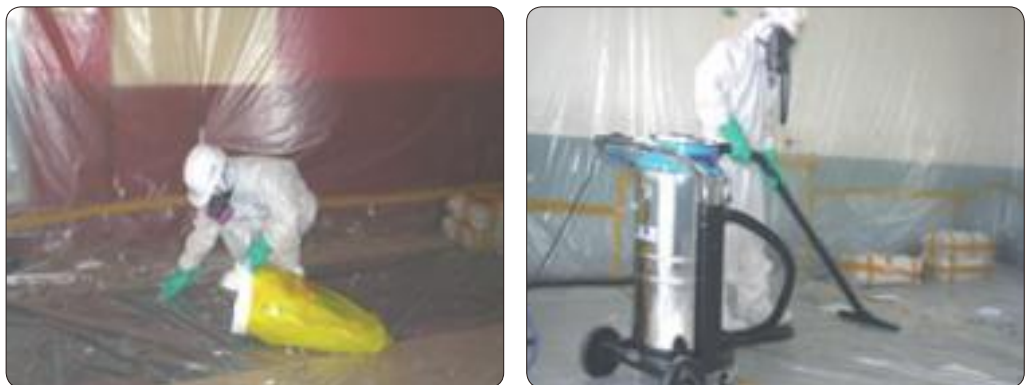
[그림 10-3] 석면함유 잔재물의 청소 모습
