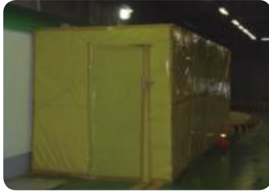
[그림 10-8] 석면폐기물 별도 보관장소 설치 예시
