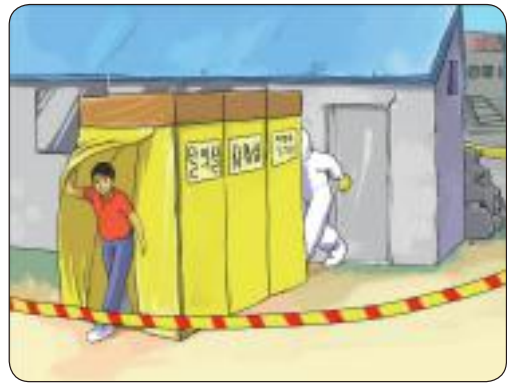
[그림 5-2] 지붕슬레이트 해체·제거작업 인근에 설치된 위생설비
