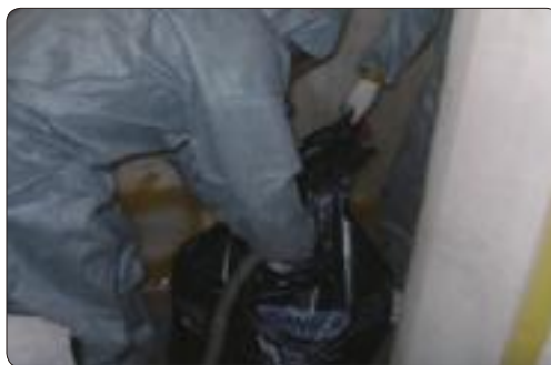
[그림 10-4] 석면폐기물 포장용기 이중 밀봉방법
