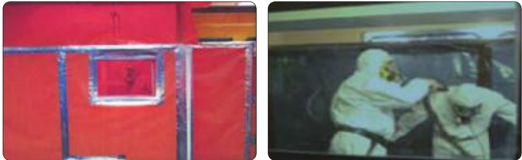
[그림 7-3] 감시창 설치 사례
